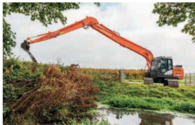
Excavadoras para aplicaciones especiales
